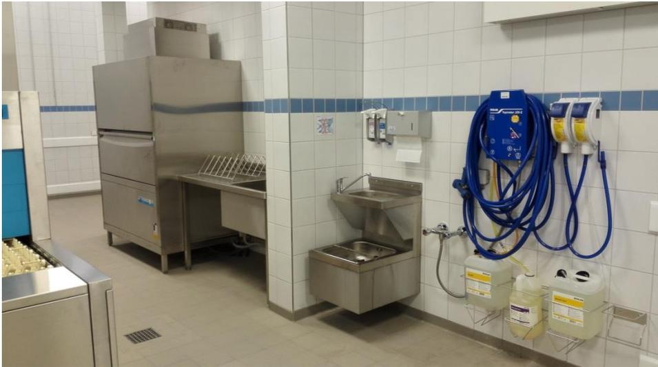
Lösung wird im Sprühverfahren auf den Boden aufgetragen. Danach wird „geschrubbt“ und wieder klargespült. Hoher Wasserverbrauch und viel mechanischer Aufwand des Personals. Die Mitarbeiter empfinden „Sprühen“ als bequem, der Chemie- und Wasserverbrauch steigt enorm an.
